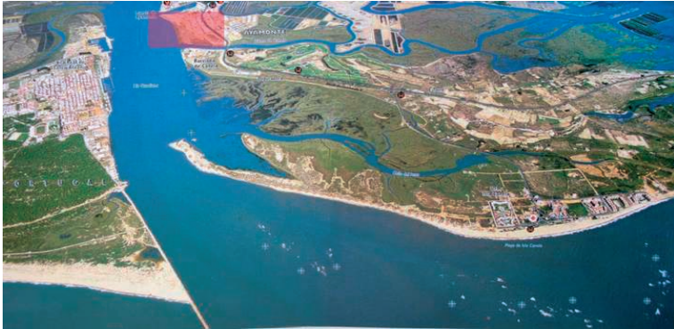
(img 30- aérea situación en Ayamonte )
